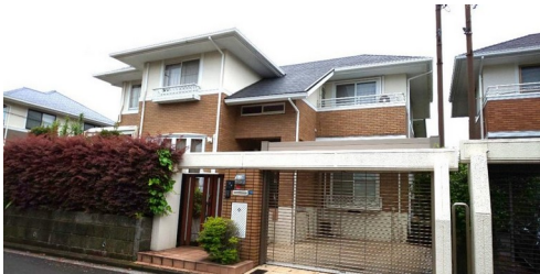
写真1 調査地①の外観（道路側）
