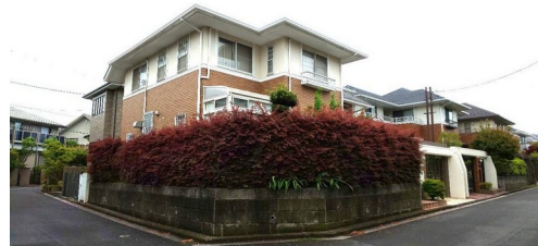
写真2 調査地①の外観（側面）。人の出入りの痕跡なし
